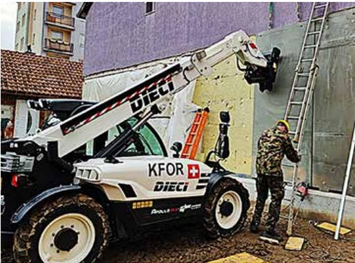
Montage und Befestigung von Fertigbauteilen zum Schutz vor Waffenwirkung sowie Wärmedämmung.
