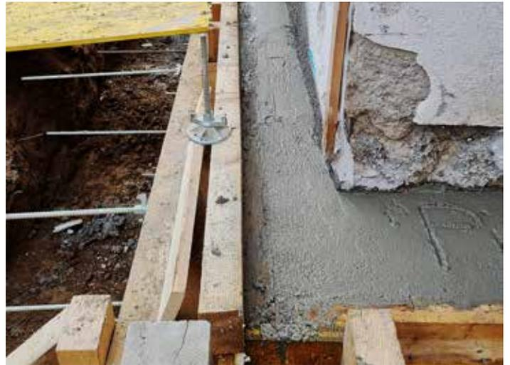
Betonierung des Fundaments aus Stahlbeton am Rande des Fieldhouses.
