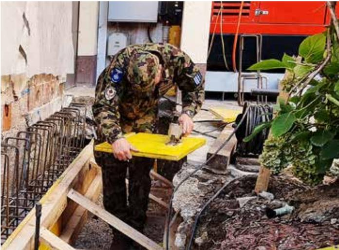
Vorbereitungsarbeiten der Schalung und Armierung durch Angehörige der Armee.
